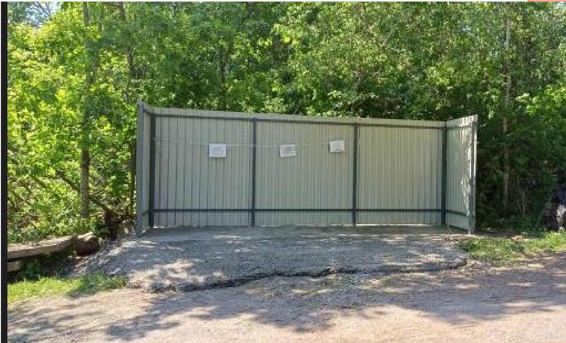
Устройство контейнерной площадки в снт Боровое
